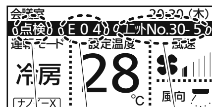
点検マーク 不具合が発生している 警報表示 室内ユニットNo
