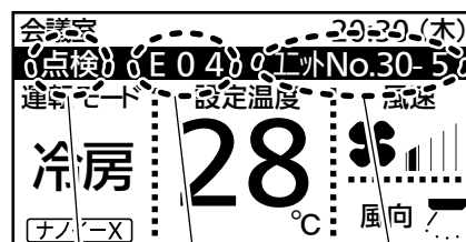
点検マーク 不具合が発生している 警報表示 室内ユニットNo
