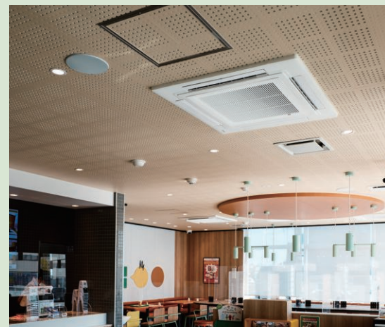
▲店内配置された4方向天井カセット形室内機 （「ナノイー X」標準搭載）
