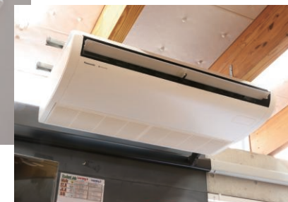
▲教室に設置された ナノイーX機能搭載の天吊形
