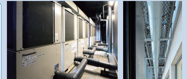
▲パッケージエアコン(3WAYマルチ) 外装リフレッシュ後のダブルスキン▶
