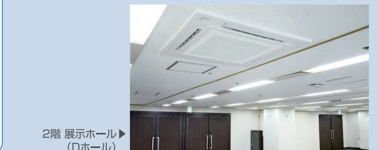
▲パッケージエアコン(3WAYマルチ) 外装リフレッシュ後のダブルスキン▶
