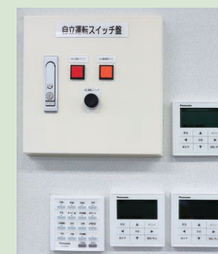
▲自立運転スイッチと制御機器
