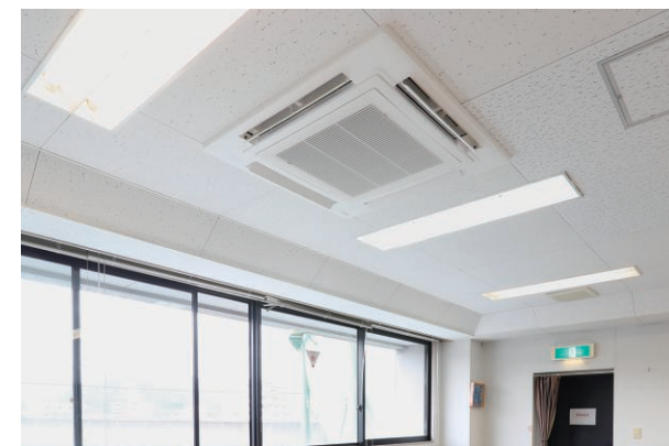
▲事務所に設置された4方向天井カセット形
