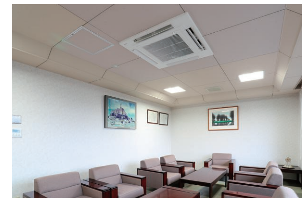
▲応接室に設置された4方向天井カセット形
