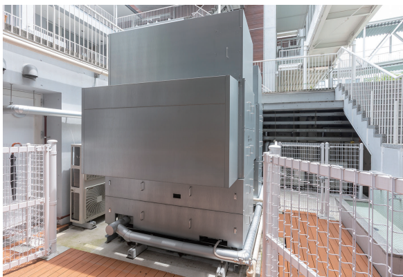
▲GHP室外機の周囲はアリーナの入口への通路となっている他、上部の吹出ファン近くには学生や教職員がくつろぐスペースもあるため、GHP室外機の吸込口と吹出口を覆う遮音器*が設置、周辺環境に配慮することで設置を実現 *遮音器は他社製作にて現地対応品となります。
