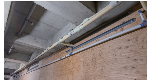
▲以前は式典時に使用する移動式観覧席を壁面内に収納していたが、観覧席を解体し、空いた壁面内側を有効活用することで配管スペースを確保
