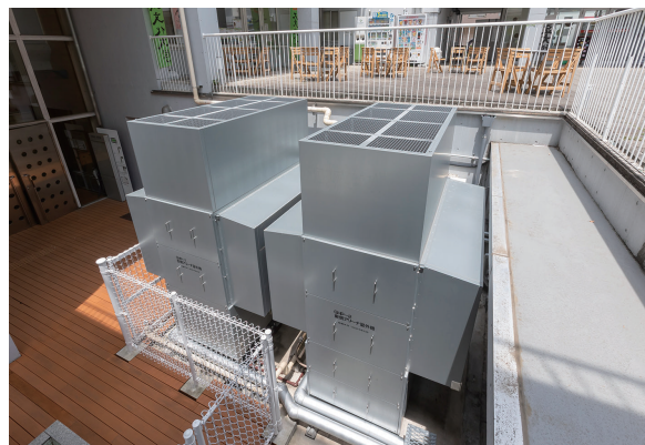
▲GHP室外機の周囲はアリーナの入口への通路となっている他、上部の吹出ファン近くには学生や教職員がくつろぐスペースもあるため、GHP室外機の吸込口と吹出口を覆う遮音器*が設置、周辺環境に配慮することで設置を実現 *遮音器は他社製作にて現地対応品となります。
