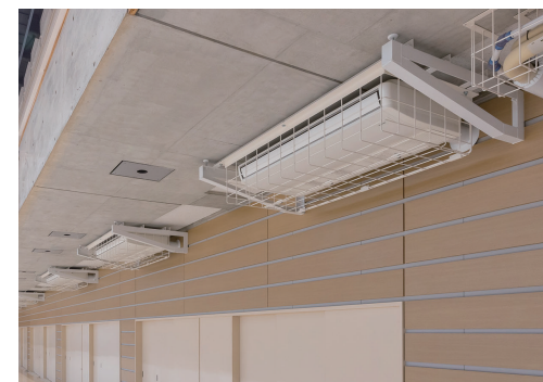
▲防球ネットで保護された天井吊形室内機
