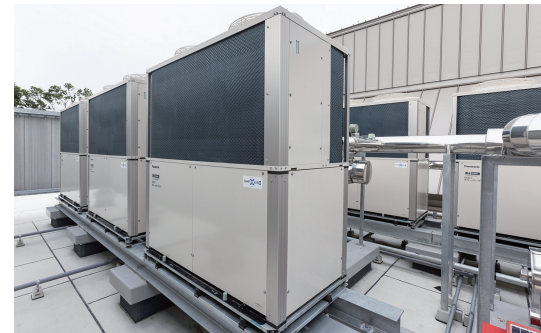
▲25馬力のGHPチラーが7台並び 全系統メインアリーナに繋がる
