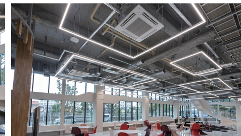
▲5.2mの天井高と吹き抜けのある学生ホールでも4方向天井カセット形ナノイーX搭載室内機が快適性を保つ
