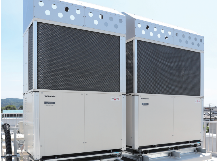
▲台数制御での運用で省エネ性を大きく向上 上部には防雪フードが取り付け
