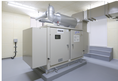
▲BCP対策として非常用発電機(油)を整備
