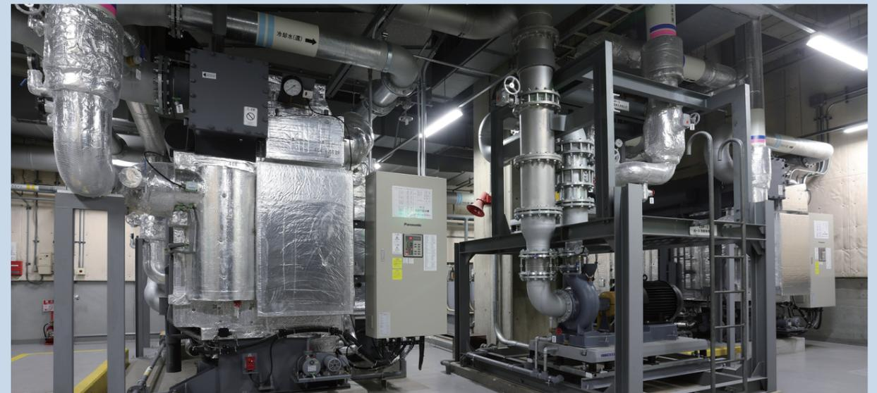
イベント時には空調負荷が大きく変動するため、本ドーム施設では高効率運転と信頼性の向上を目指し、開業当初から電気とガスのベストミックスによる空調設備設計が行われています。今回、当ドーム施設の空調熱源機のリニューアルに際し、当社のナチュラルチラー高期間効率機R型を3基採用いただきました。
