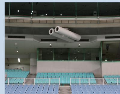
循環流ファンが10台、観客席に沿って風速0.5~1mの人工的な風を発生させています。人の感じる温度は風速0.8mのそよ風があれば、室温より約2℃低く感じるとされており、省エネと快適性を実現しています。
