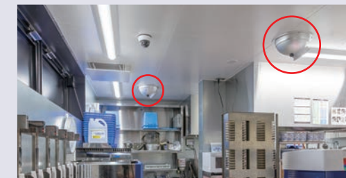
▲厨房 (ビルトインカセット型室内機とパンカールーパーの組合せ)
