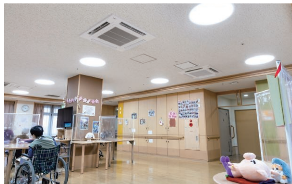
▲食堂(停電時に照明が点灯)
