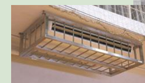
▲室内機 (天井吊型 4馬力×4台)
