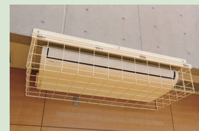
▲1階はボール除けの網を設置
