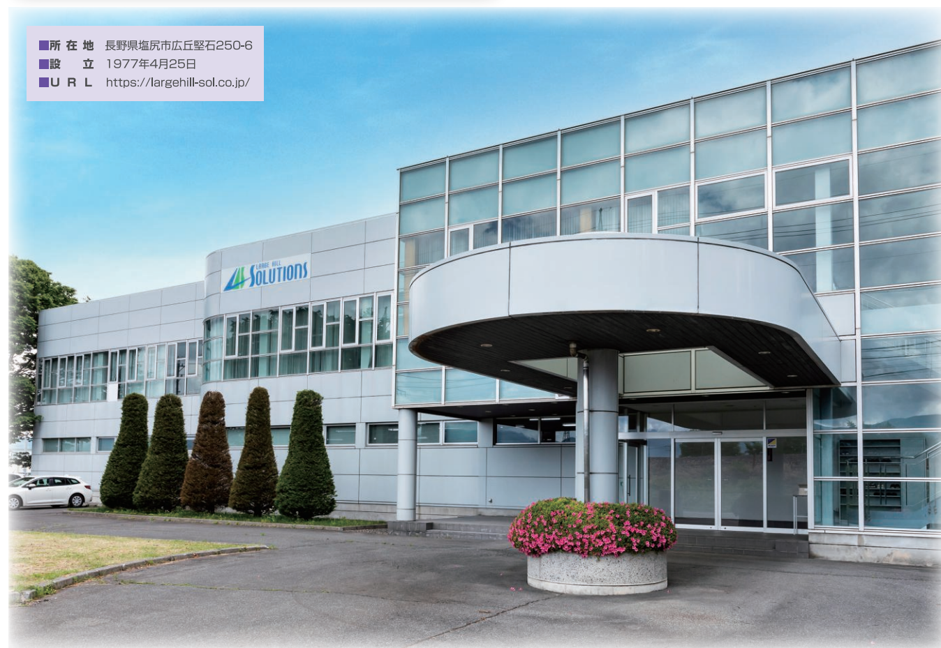
▲外観 事務所兼管理棟他、組み立て工場A棟B棟があります。
