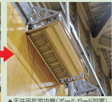
▲天井吊形室内機(ボールガード設置) 昇降グリル採用
