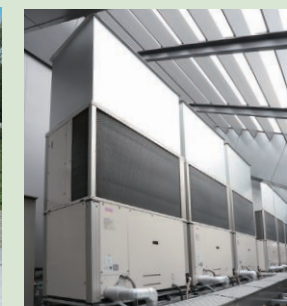
▲室外機ファン上部にダクト設置
