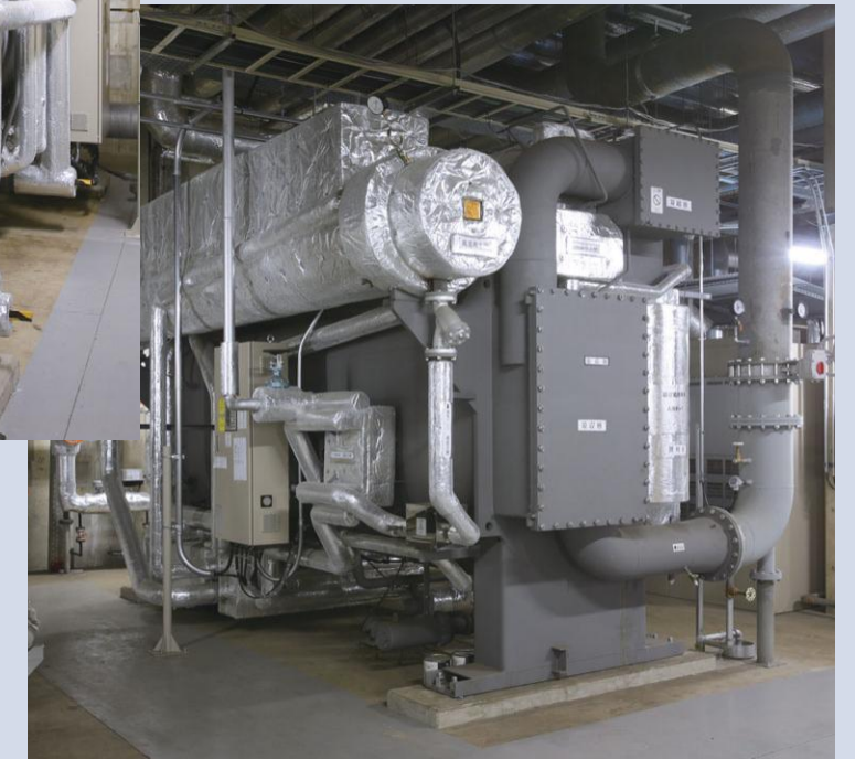
▼蒸気二重効用吸収冷凍機
