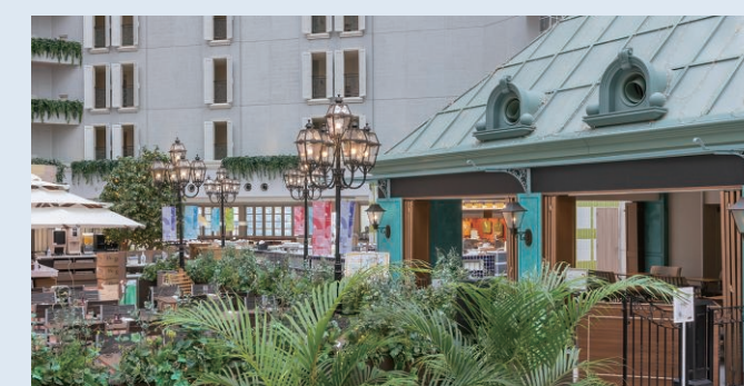
▲レストラン屋根の装飾に見立てた空調吹き出し口
