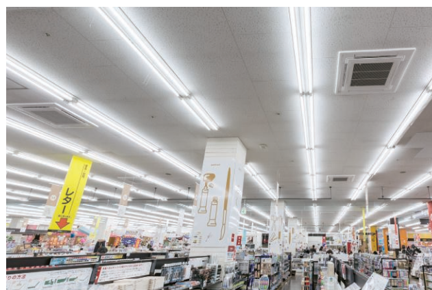
▲4方向天井カセット形室内機
