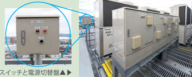
▲自立運転スイッチと電源切替盤
