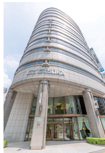
▲甲州街道側 出入口
